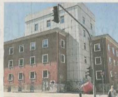
Das alte Finanzamt wird abgerissen.
